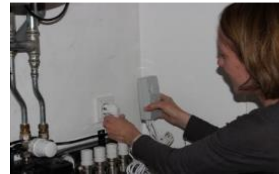
pompschakelaar bij vloerverwarming
