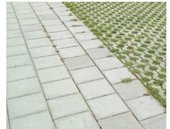
B. trottoirs van tegels om tot de woning te komen
