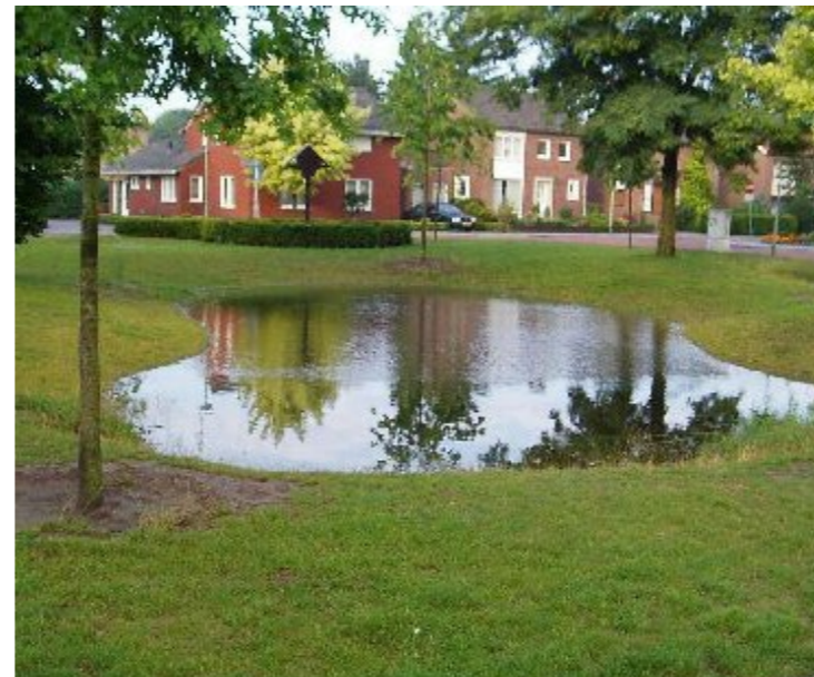
wadi als tijdelijke waterbuffer in de buurt na piekbuien
