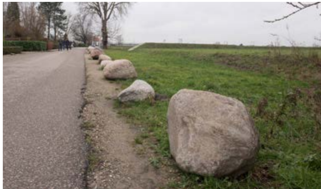
zwerfkeien als maatregel tegen parkeren in de berm
