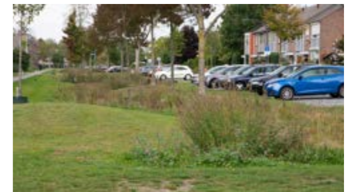
C. buurtgroen komvormig aanleggen met wateropvang
