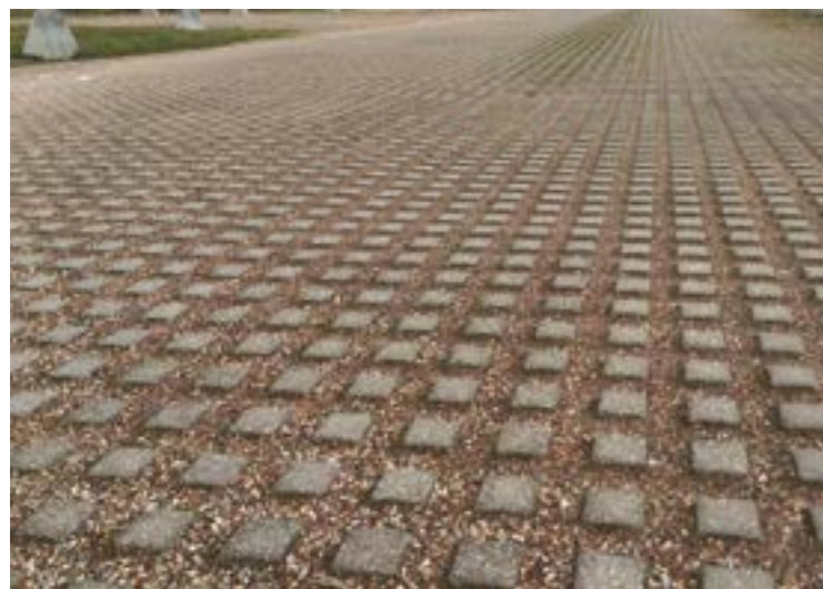
referentie grasbetontegels gevuld met split voor onder carport
