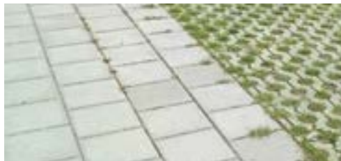
trottoir van betontegels
