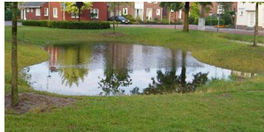
voorbeeld van een tijdelijk bufferende wadi
