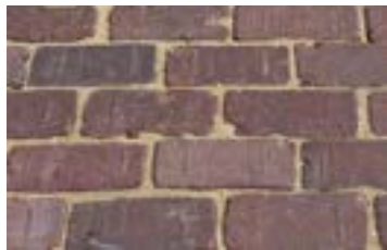
rijstroken: gebakken klinkers halfsteensverband
