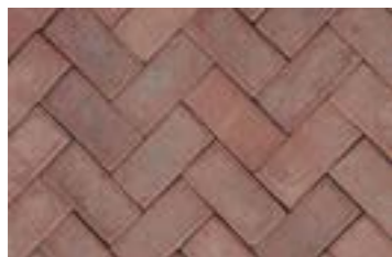
rijbaan: gebakken klinkers keperverband
