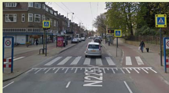
Verandering van de inrichting van de provinciale weg (N225 Oosterbeek ter hoogte van het centrum)
