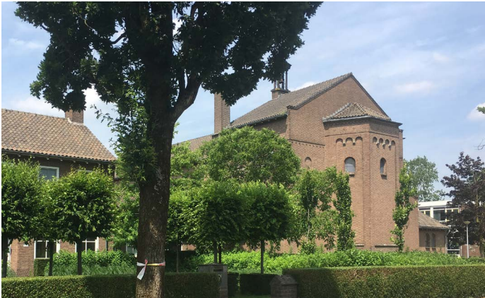
Augustinuskerk als voorbeeld van een wederopbouwpannd
